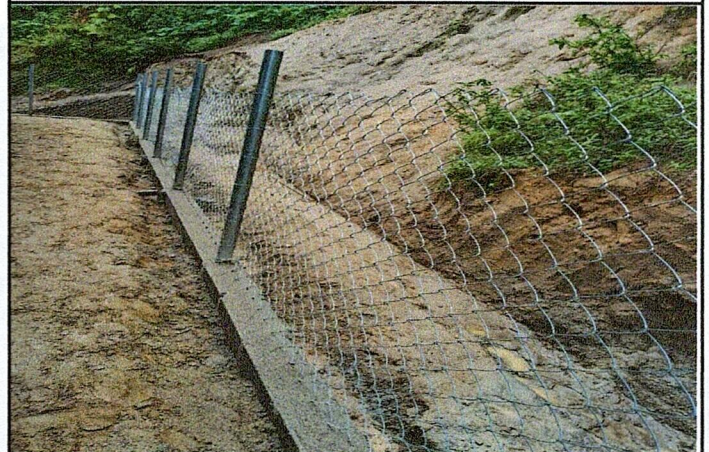
Foto 4: Circulación finalizado parte de atrás del centro educativo.
