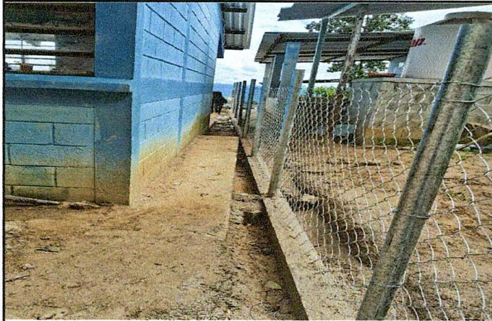
Foto 3: Circulación terminado parte lateral del centro educativo.
